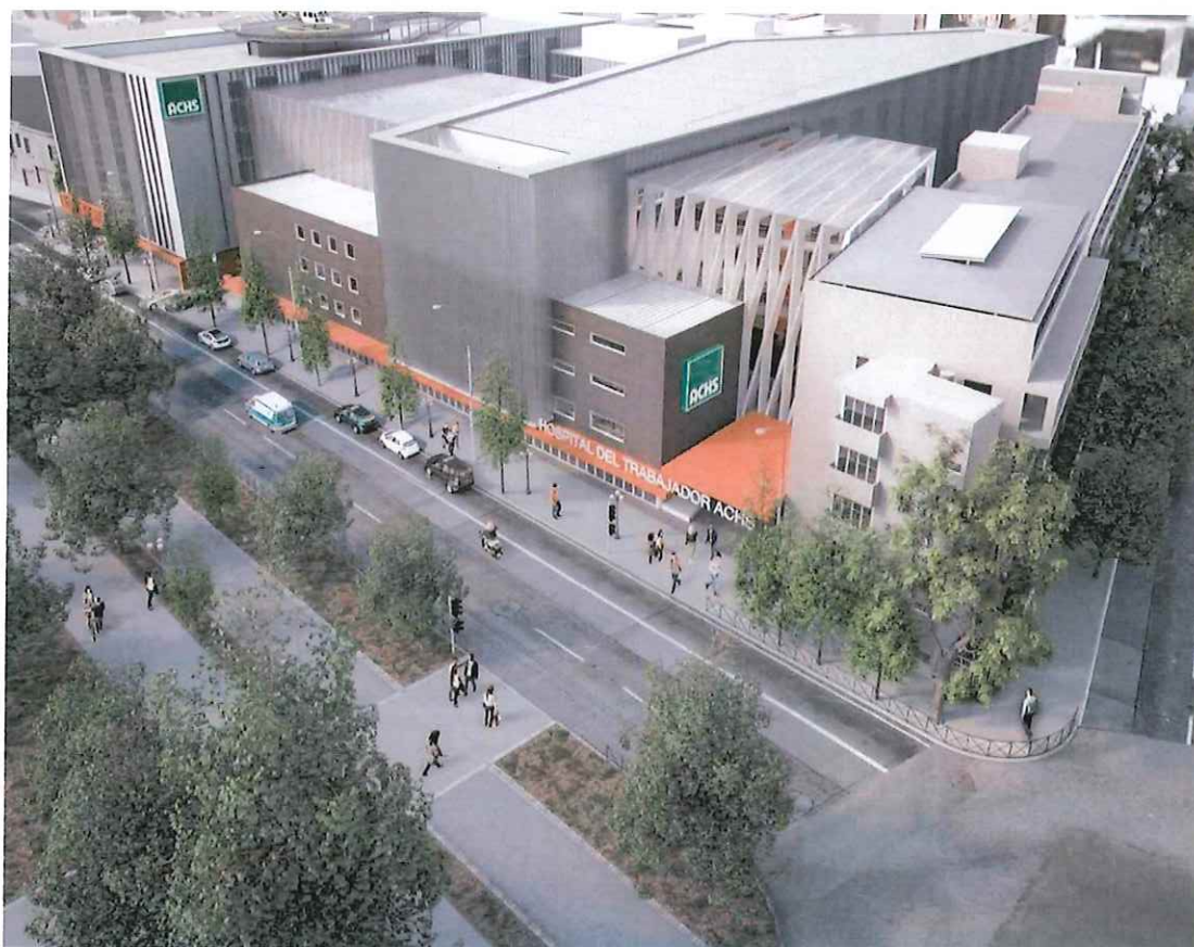
HOSPITAL DEL TRABAJADOR - ACHS
